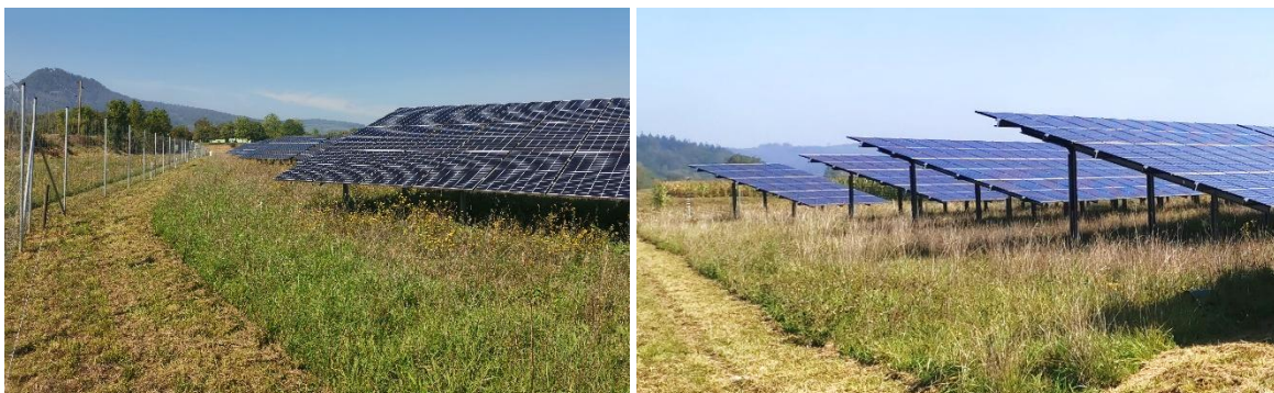
Abb. 16: Beispiel eines südexponierten Solarparks, Abgrenzungszaun aus Knotengeflecht (Quelle: solarcomplex AG, Solarpark Brächle, Engen, Sept. 2023).
